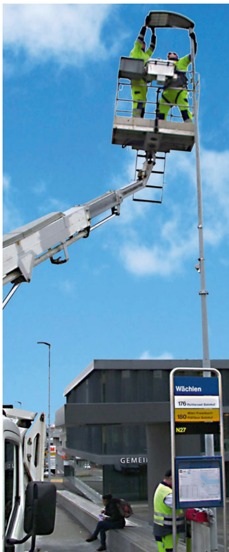
Montage der Leuchten. Bild: Gemeinde Wollerau
