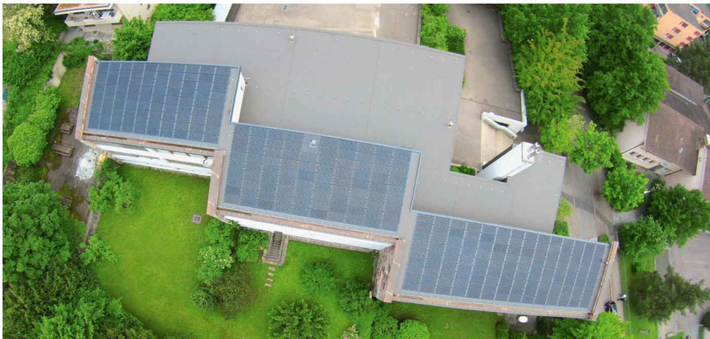
Photovoltaikanlagen auf dem Dach des Schulhauses von Thalwil.
